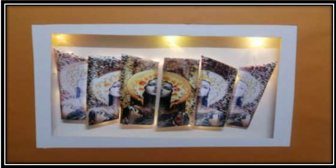
(العمل رقم 2 : وحدة اضاءة غير مضيئة )
