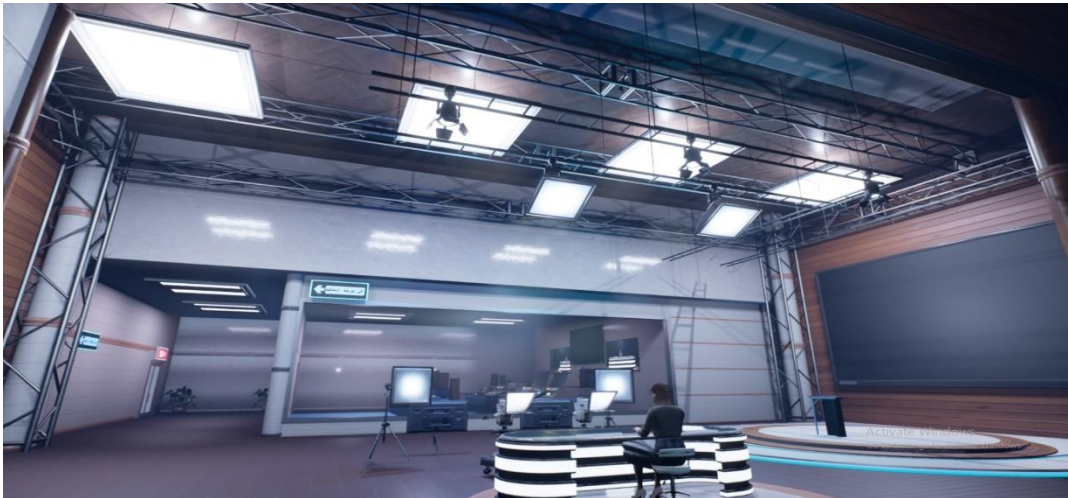
شكل (10) شبكة إضاءة الاستديو التلفزيوني.
