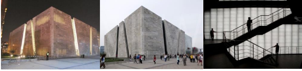
صورة (12) توضح شكل الخرسانة الشفافة المستخدمة في المعرض العالمي بشنغهاي بالصين
