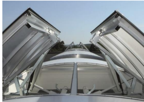
صورة (7) السقف الذاتي الاستجابة في مكتبة فليجو في ولاية كاليفورنيا
